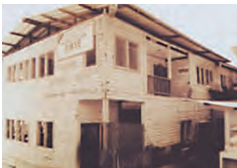
Edificio de madera donde funcionó el Sindicato General de Trabajadores de CIMA S.A.
